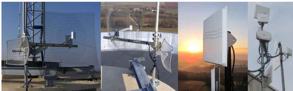
Figure 16 : réseaux Wi-Fi WiMax 5 GHz
