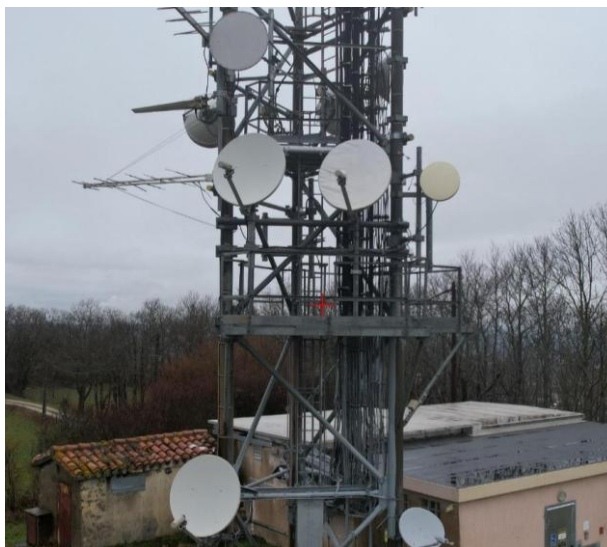
Figure 24 : exemple de cohabitation entre antennes satellites et antennes FH
