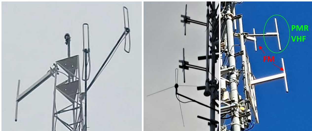
Figure 65 : exemples de découplages insuffisants entre réseaux PMR VHF et radiodiffusion FM
