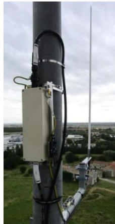
Figure 59 : modem 868 MHz générant des brouillages radio VHF lorsque ce dernier est situé dans des champs trop forts
