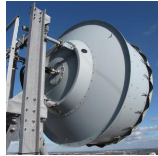
Figure 21: antenne à deux entrées (une par polarisation), alimentée par des guides d'onde flexibles (parties actives, modulation et amplification, déportées)
