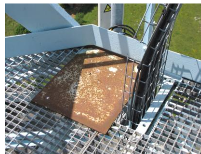
Figure 32 : dans ce cas, l'ouverture de la trappe influait sur l'amplitude des produits d'intermodulation
