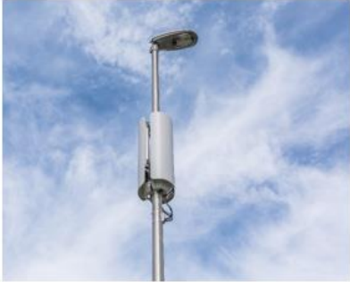
Antennes intégrées au mobilier urbain
