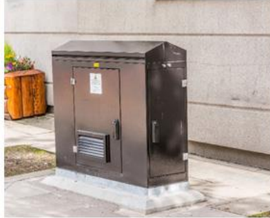
Antennes intégrées au mobilier urbain
