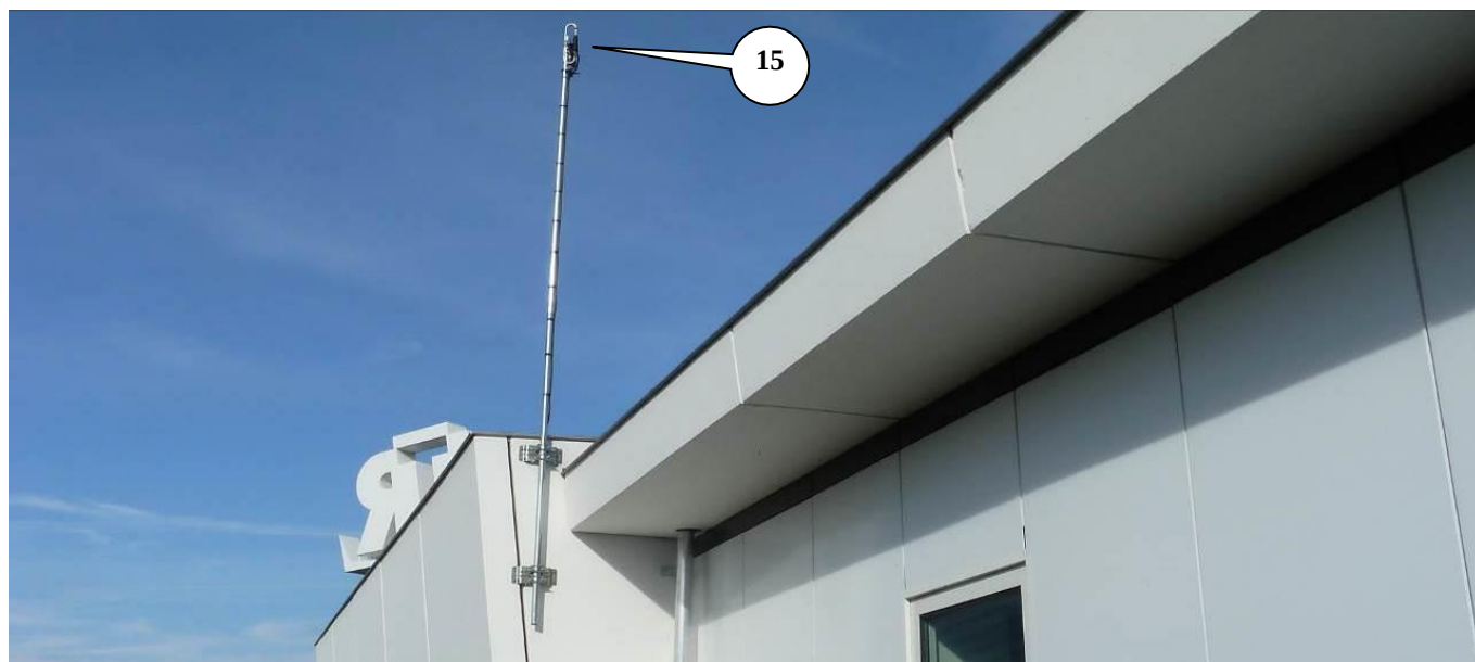
Vue générale du bâtiment accueil ATR
