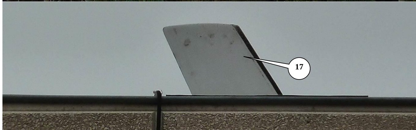
Vue générale du bâtiment Aéro Vision Impasse Santos Dumont
