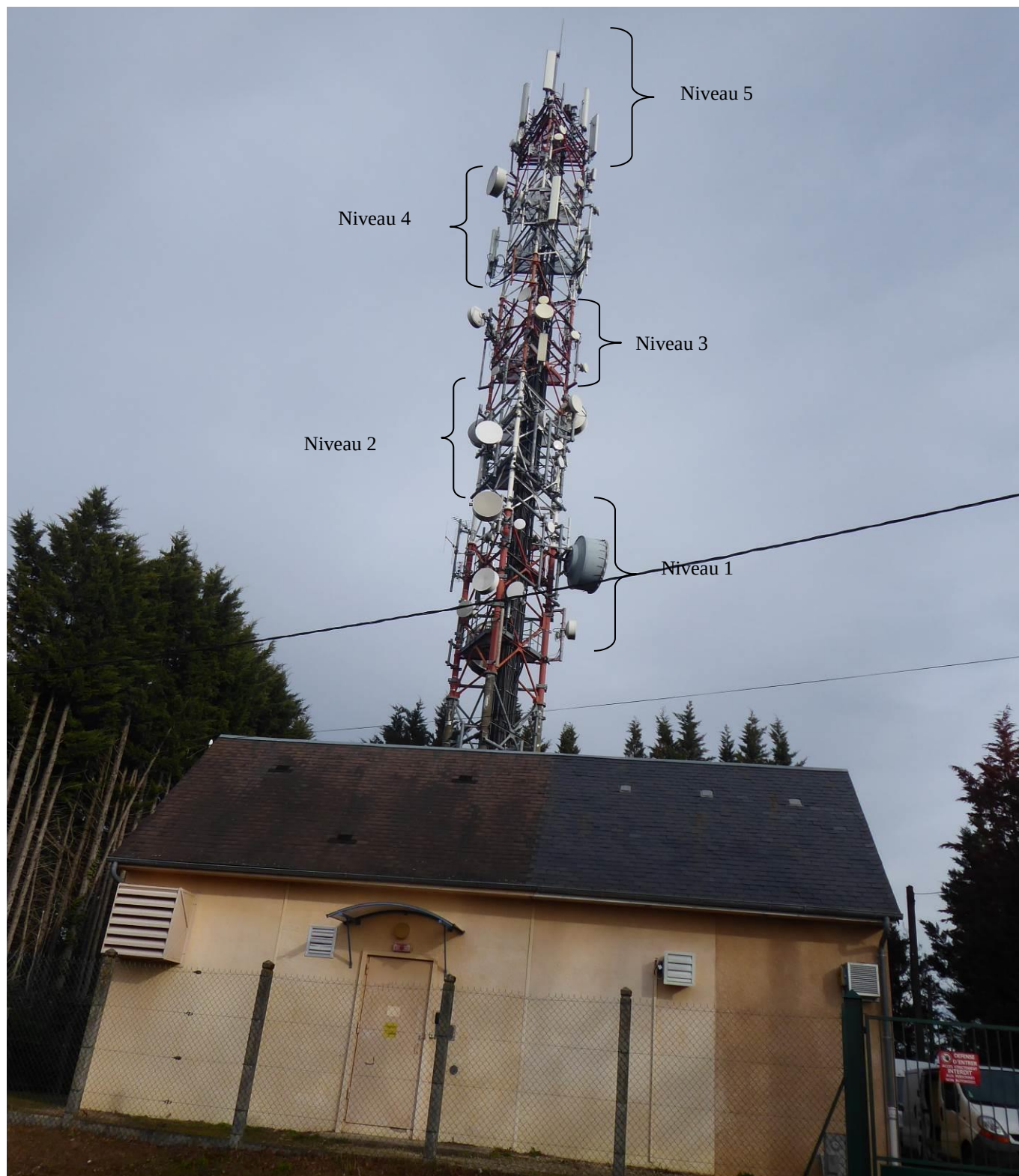
Vue générale depuis azimuth 190° du pylône
