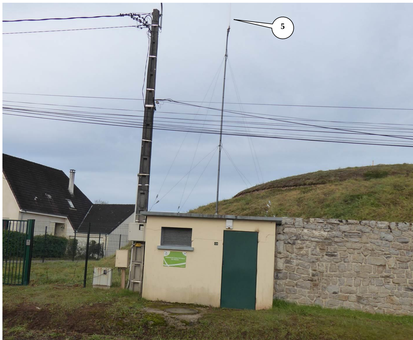
Vue depuis azimut 100° du bâtiment
