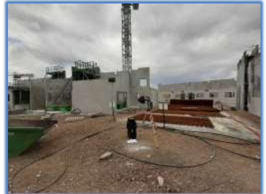
Mesures sur le chantier du centre pénitentiaire de Koné
