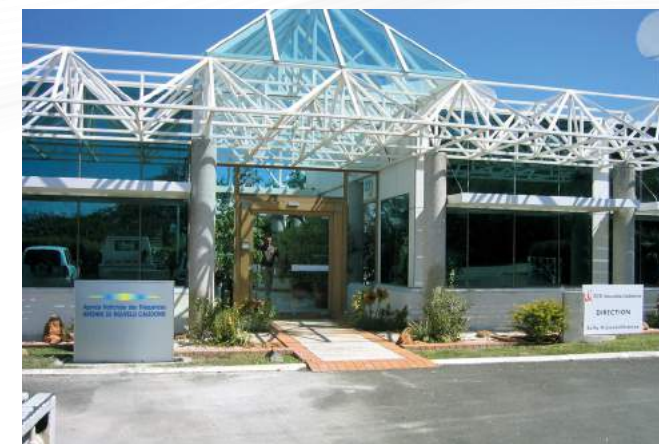
Antenne de Nouvelle-Calédonie
