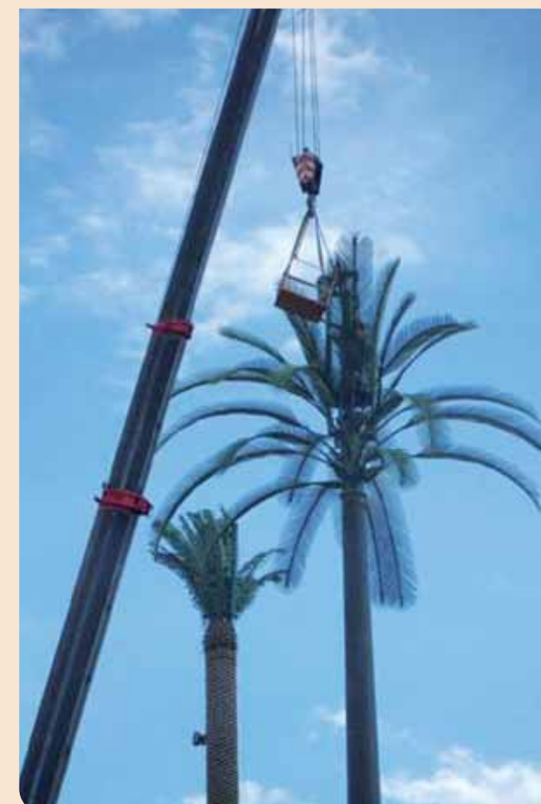
Installation d'un relais GSM à la Réunion | □
